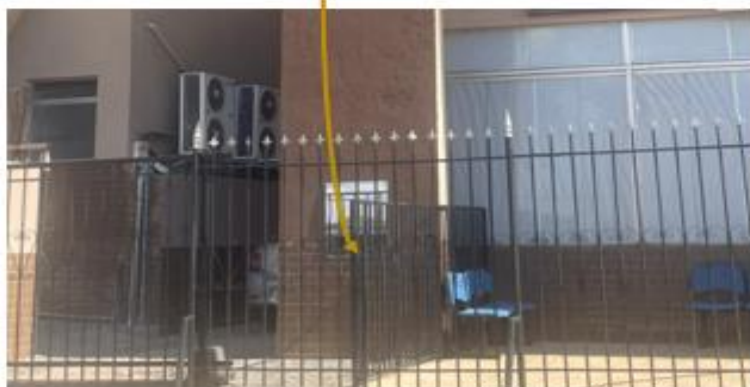
Imagens da fachada após a reforma.
