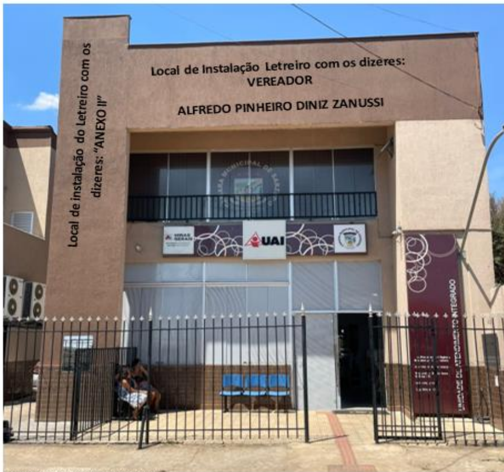
Imagens da fachada após a reforma.
